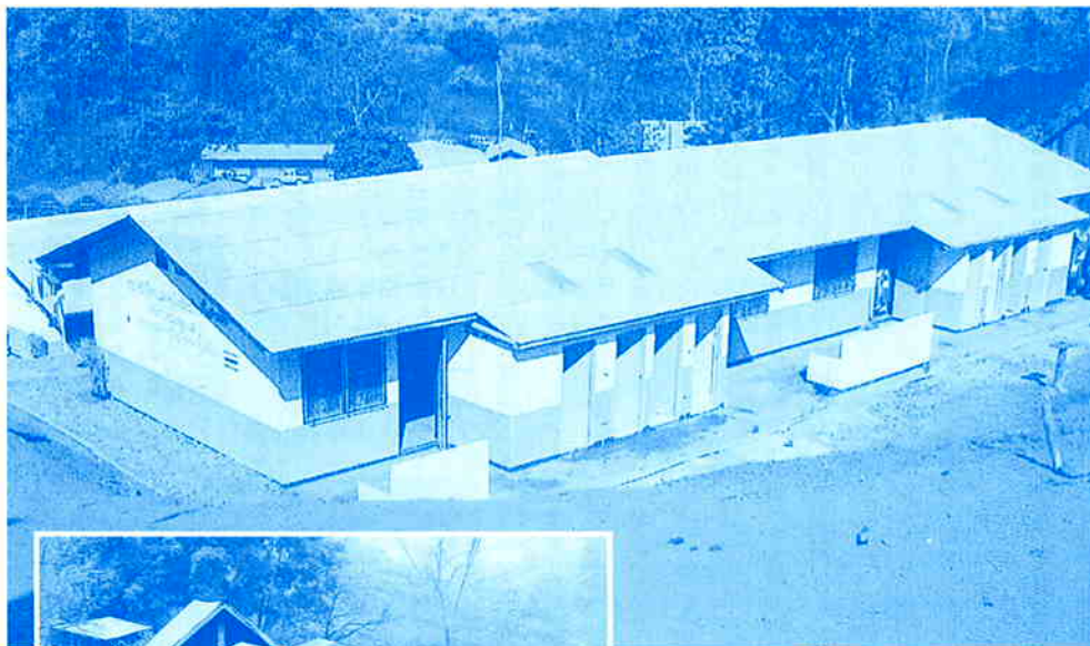
▲前方が男子用、後方が女子用寄宿舎。ベッド、シャワー、ロッカーも備え、太陽光発電も取り入れた鉄骨モルタル造りの近代的な建物です。
