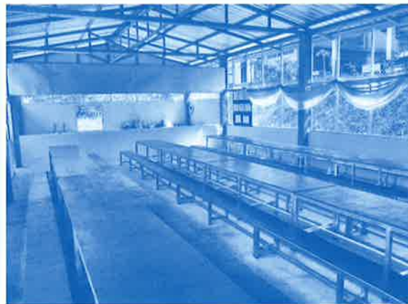
▲完成した食堂内部の様子
