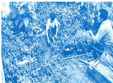
▲水道配管の修復工事の様子
