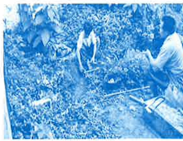
▲緊急支援 飲料水用設備工事の様子
