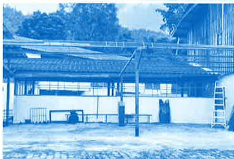
▲保健室建設予定地(2020年10月時点で基礎工事で完了)
